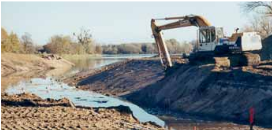
Sensibles Arbeiten mit schwerer Technik
